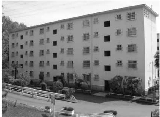
多摩ニュータウンのみならず全国において、エレベーターのない中層の集合住宅が大量に建設された。なかでも階段室式の住宅は、各住戸と階段室の位置関係からプライバシーや窓からの眺望に配慮された構造となっていることに特徴がある。ただし、エレベーターを後から設置するには通常階段室ごとの取り付けが必要となるため、1基を設置すればすむ片廊下式の住宅と比べてコストがかかる
